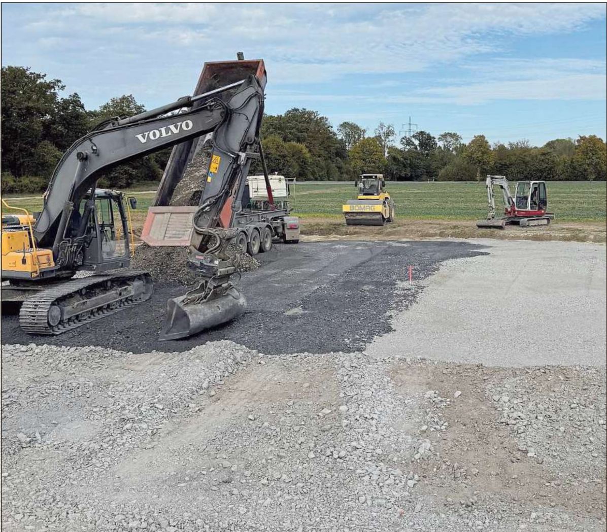
Auf den Flächen zwischen Ahlen und Neubeckum entstehen drei neue Windenergieanlagen mit einer Gesamtleistung von 21,6 Megawatt. Auch die Stadt soll profitieren. Foto: Wißling
